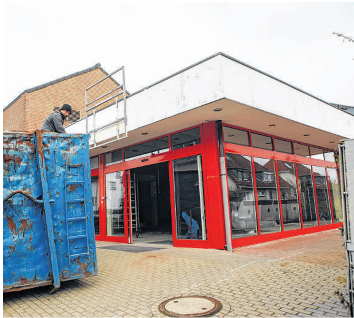
Der ehemalige Penny-Markt an der Überrauchstraße wird zur neuen Kita des SkF umgebaut.
